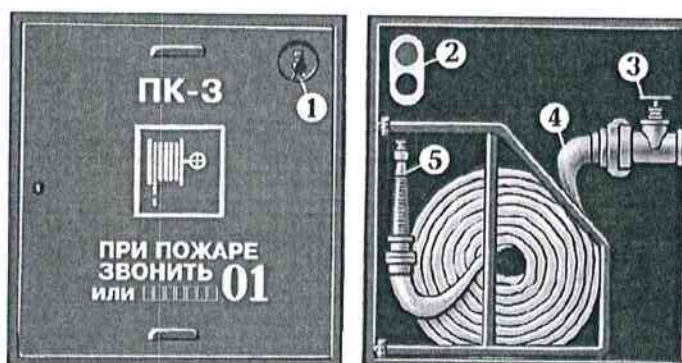
Рис. 10. Внутренний пожарный кран: 1 — место хранения ключа; 2 — пульт дистанционного включения насосоповысителя; 3 — пожарный кран; 4 — пожарный рукав; 5 — ствол
